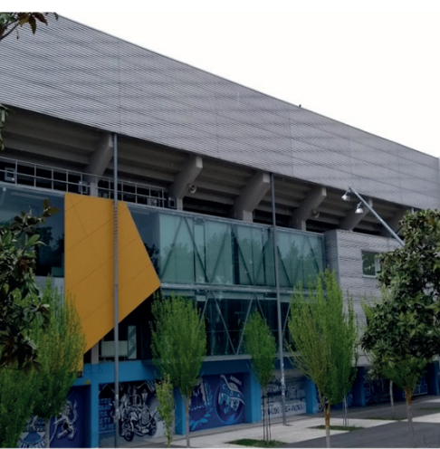
FACHADA FONDO POLIDEPORTIVO
