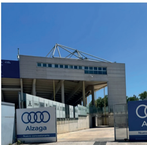
VISTA DE CELOSIA DESDE EL EXTERIOR
