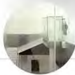
Museo del siglo XXI, Sanaa Frente del forjado y barandilla
